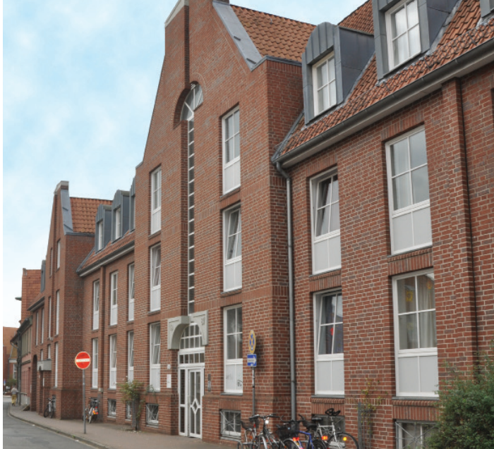
City-nah und gemütlich: Wohnheim „Salzbrücker Straße“
